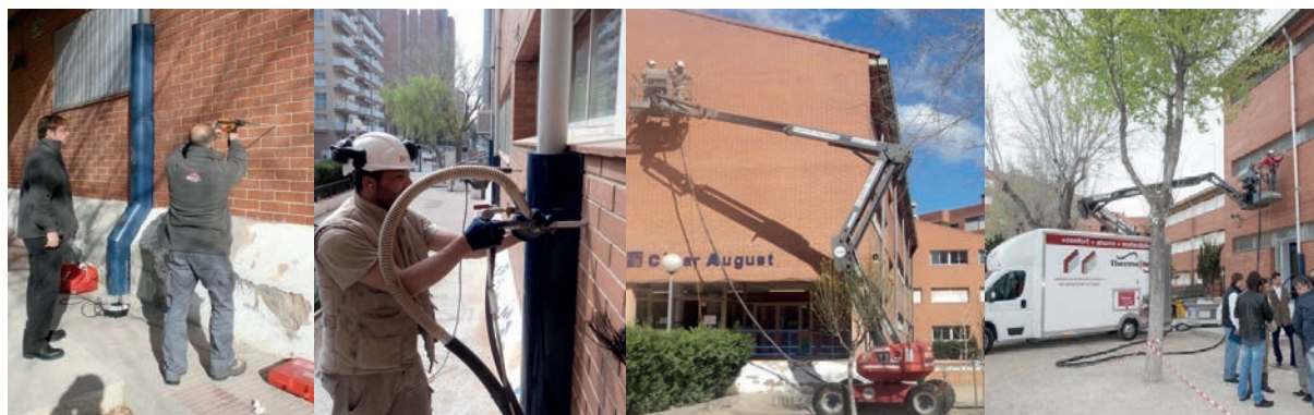
Figura 2. Proceso de instalación del sistema ThermaBead
